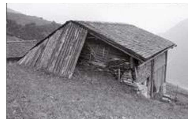
Das Wohnhaus 1979. Verschindelter Blockbau, wohl in der Mitte des 17. Jahrhunderts als Doppelwohnhaus errichtet mit zwei Stuben und Kammern im Vorderhaus. An der südlichen Traufe ein später angebautes Zimmer. Das Dach ist mit Schindeln eingedeckt. Rundhölzer, vom Hang her an die bergseitige Dachkante gelehnt, schützen das Haus gegen die erheblichen Druckkräfte von Kriechschnee. (Fotos © Benno Furrer, 1979) (Foto Haus mit Stall © Murer/Corradi 1983)
