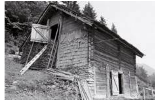
Zwei Weidställe auf Wasserplatten. Es gilt: Das Vieh geht zum Heu – und nicht umgekehrt. Links Heustall jüngeren Typs, rund 60 m oberhalb des Wohnhauses. Der Stall ist quer zum Heuraum angeordnet, das Heu wird über eine Leiter zum Heutor hochgetragen. Rechts: Heustall älteren Typs, rund 60 Höhenmeter unterhalb des Wohnhauses. Stall und Heuraum liegen firstparallel übereinander. Das Heu kann bergseitig relativ leicht durch das Heutor eingebracht werden. (Fotos © Benno Furrer, 1979)
