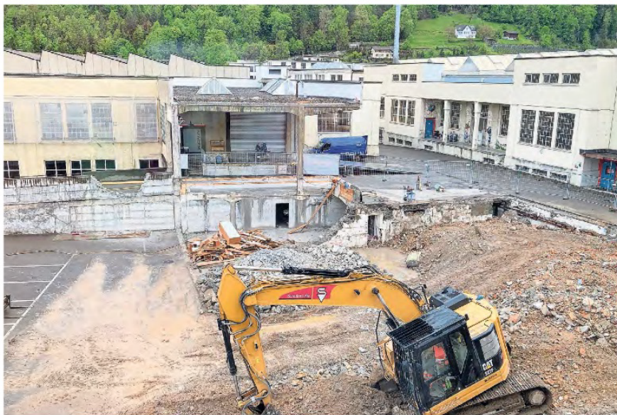
Vom einstigen Kesselhaus ist nichts mehr zu sehen. Bis Ende Juli sollen die Arbeiten abgeschlossen sein und die neue vergrösserte Parkfläche den Besuchenden des Dätwyler-Areals zur Verfügung stehen. FOTO: ZVG
