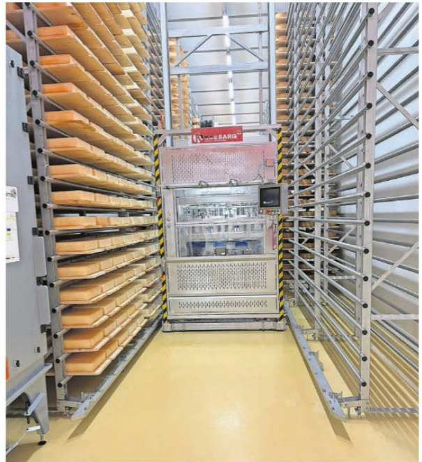
Herzstück der Anlage ist der Käsepflegesmierroboter. Er erledigt die schweren und zeitintensiven Arbeiten.
