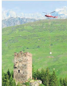
Die Stahlkonstruktion wurde mithilfe des Helikopters in den Turm eingebaut.
