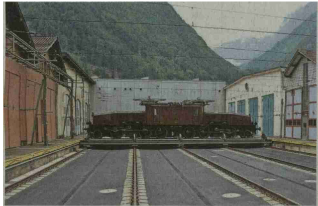
Auch die Schiebebühne der Landesausstellung von 1914 war Teil der umfangreichen Sanierung.
