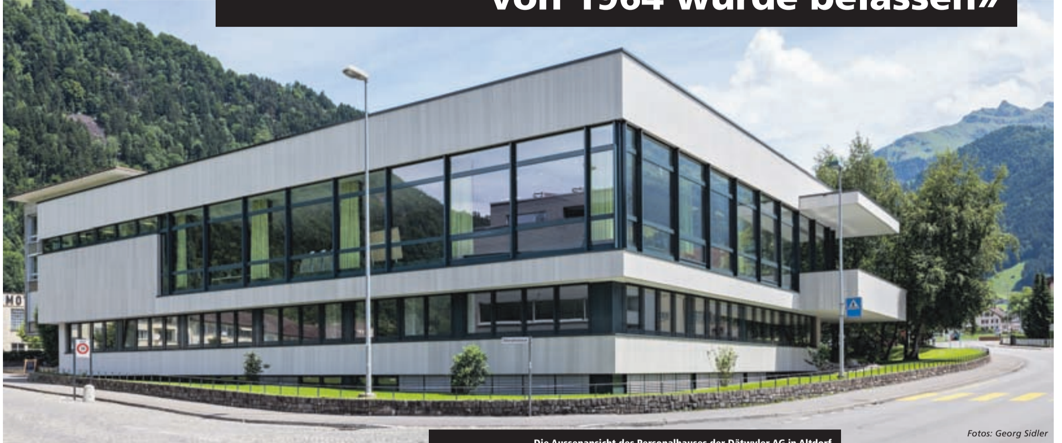
Die Aussenansicht des Personalhauses der Dätwyler AG in Altdorf.
